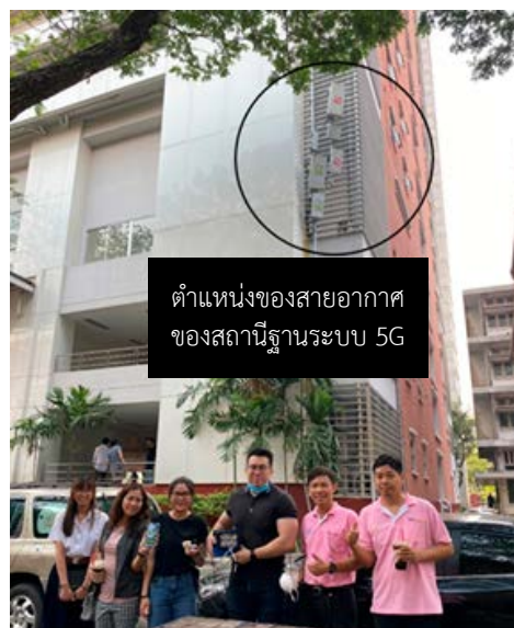
ภาพที่ 4 สถานีฐานระบบ 5G ที่ติดตั้งในพื้นที่บริเวณคณะวิศวกรรมศาสตร์ ที่มา : ภาณุวัฒน์ จันทร์ภักดี และคณะ (2563)
