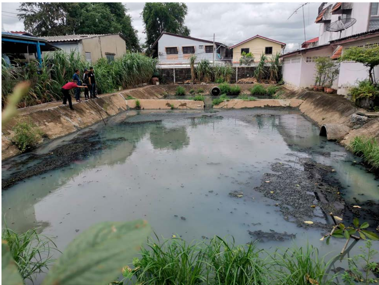
ภาพที่ 3 สภาพบ่อบำบัดน้ำเสียของชุมชนตอนเมืองวิลลา ก่อนการบำบัดน้ำเสียด้วย EM ที่มา : เพชญ์ ภัคโชตานนท์ ถ่ายเมื่อ กันยายน 2563
