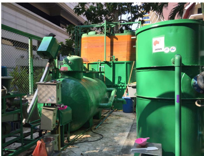
ภาพที่ 2 ระบบถังหมักขั้นตอนเดียว ที่มา : Ratanatamskul et al. (2014)
