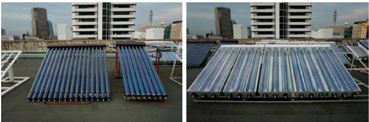
ภาพที่ 7 แผงรับแสงอาทิตย์แบบท่อแก้วสุญญากาศ (ซ้าย) แผงรับแสงอาทิตย์ที่พัฒนาขึ้นจำนวน 5 แผง (ขวา) ที่มา : วัฒนา รติสมิทธิ์ ถ่ายเมื่อ ธันวาคม 2558
